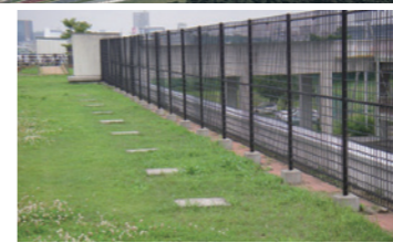
汚水処理施設の屋根部分の芝生広場に設置
