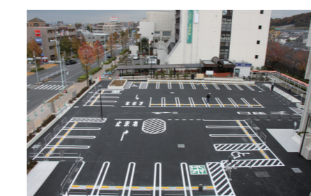
11月27日 市役所第一駐車場の改修工事が竣工、歩車分離とバリアフリー化を配慮
