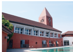
若葉台小学校体育館
