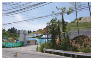
都道読売ランド線の工事現場
