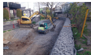
大丸用水・管堀の整備工事
