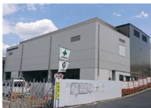
建設中の新第一調理場
