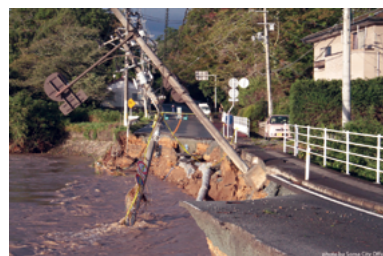
西山地区の道路洗掘
