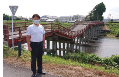
橋脚が破壊された中橋
