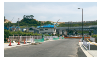
築造中の多 7・4・5 号線
