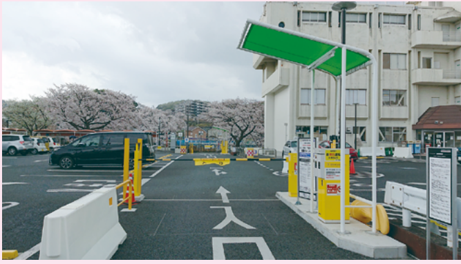
3月28日 市役所駐車場（第一～第三）の工事が完成し、有料化を開始。不適切利用と慢性的な満車状態を解消。
