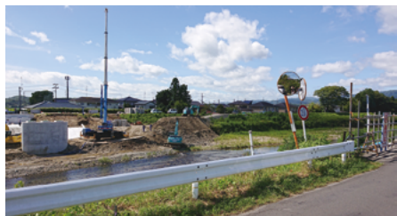
橋脚が折れた中橋の架け替え
