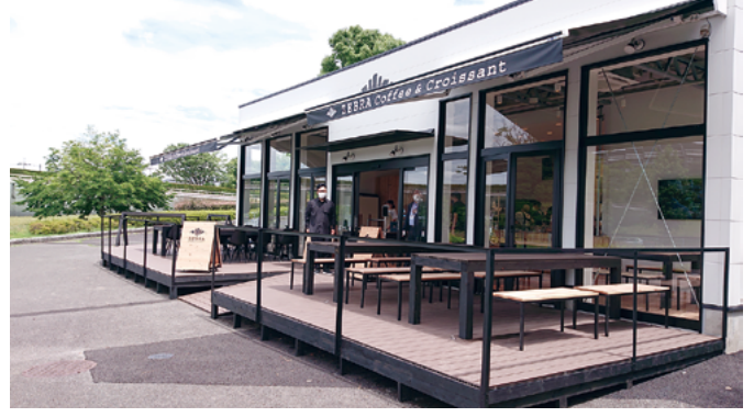
6月29日 稲城中央公園の一画、くじら橋前にサイクルカフェが完成。公募によるプロポーザル方式で選定された ZEBRA COFFEE が運営。五輪自転車ロードレースのレガシーに。
