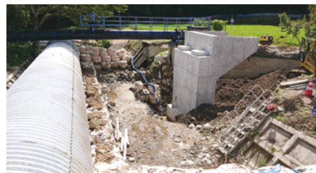
洗掘された胡桃坂橋の架け替え
