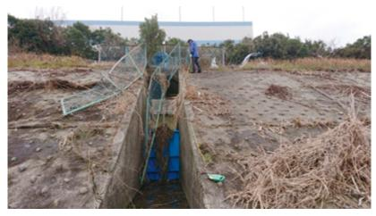
写真 3-6 令和元年(2019年)の台風 19号により被害を受けた水門
