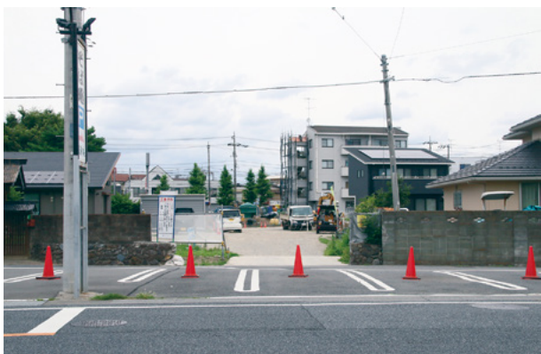
⑫多7・5・3号道路の新設
