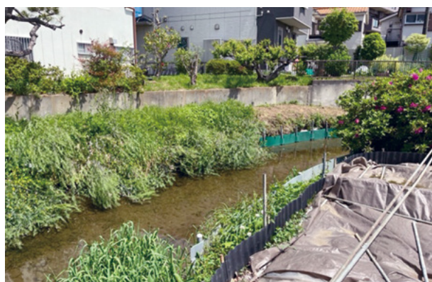
⑯大丸用水管堀の護岸整備
