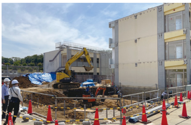
② 南山小学校増築工事
