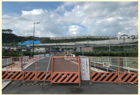
開通を目指して工事中の多摩都市計画道路7・4・5号東長沼矢野口線
