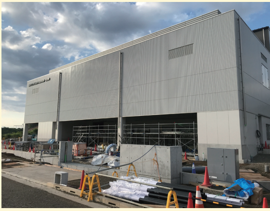
建設中の学校給食共同調理場 第一調理場
