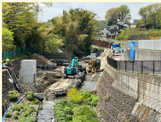
坂浜の三沢川・新きさらぎ橋周辺
